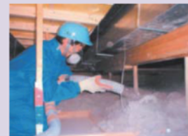
天井の断熱改修
