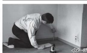
レーザー測定器で床や柱の傾斜をみたり、雨漏りの有無など、全体を診断します。
