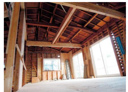
<施工中(構造躯体まで解体した状態)>
