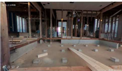
改修工事における基礎・躯体の再活用
