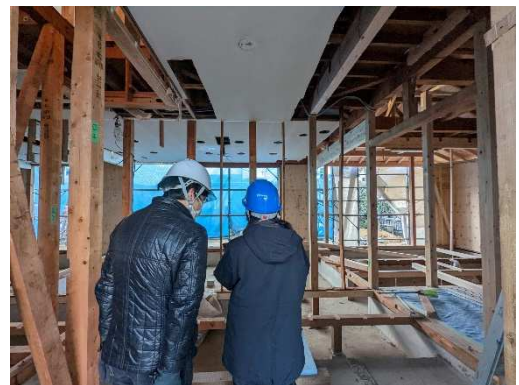
改修現場の実地調査
