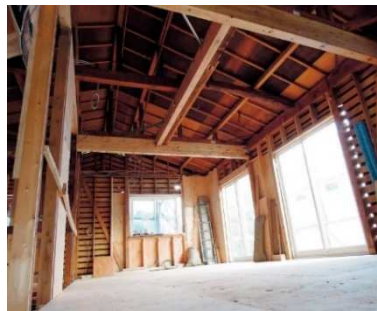
施工中(構造躯体まで解体した状態)
