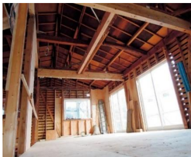
施工中(構造躯体まで解体した状態)
