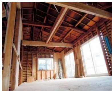
施工中(構造躯体まで解体した状態)
