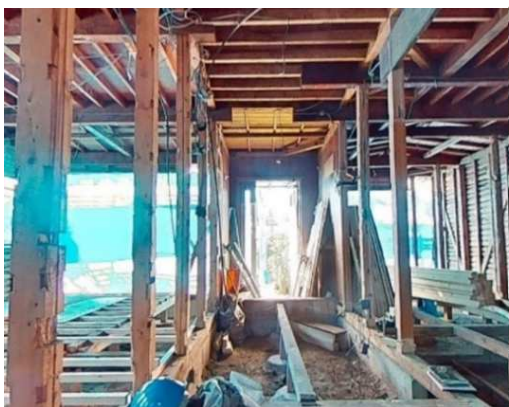
<再活用される構造躯体>
